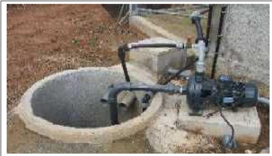
Principe de fonctionnement. Un réservoir cylindrique d'une hauteur de 2m et de 1m de diamètre intérieur est placé verticalement. Il contient le mélange (tiquicide + eau) dilué à 0,2%. Une pompe électrique permet d'envoyer la solution dans un circuit sous une pression de 4 bars.
